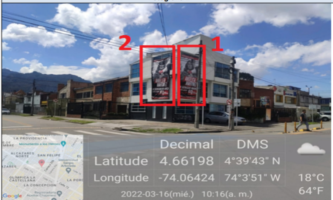
Foto 2 Vista Panorámica del predio ubicado calle 72 A No. 20 B – 77, donde se evidencian dos (2) avisos tipo fachada uno por la calle 72 A y otro por la carrera , con publicidad política los cuales hacen alusión a la candidata ANGELICA ROCÍO MARTÍNEZ TORRES del partido NUEVO LIBERALISMO "
